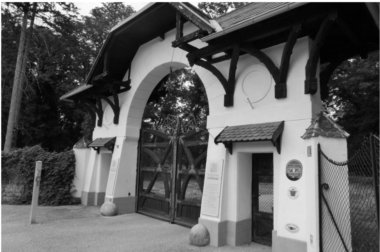
Abb. 8: Heutige Ansicht des ehemaligen Zufahrtstors in das Transitlager Schönau.
